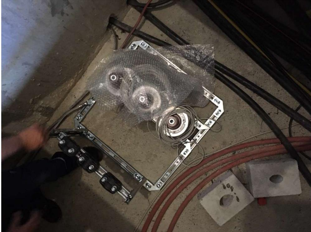
Bild 3: Spannungswandler der Fa. Ritz berührungssicher
