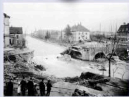
Die zerstörte Schwabentorbrücke beim schweren Hochwasser am 8./9. März 1896. Die Wassermassen rissen damals zwei Personen mit in den Tod und überschwemmten größere Bereiche der Oberau. Die Abflußmenge betrug nach Berechnungen etwa 275 m 3 in der Sekunde.
