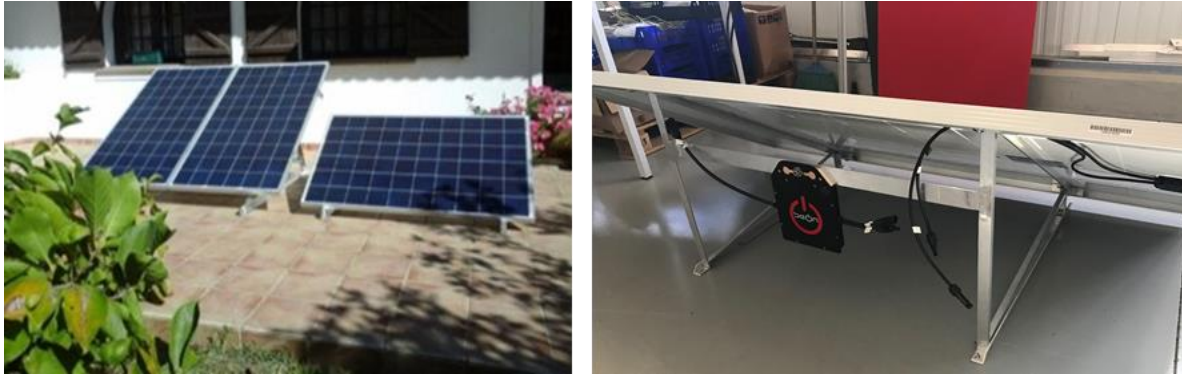
Abbildung 1: Beispiele für MikroPV-Anlagen, im rechten Bild in der Bildmitte der zur Anlage gehörende Wechselrichter, Quelle: BeOn
