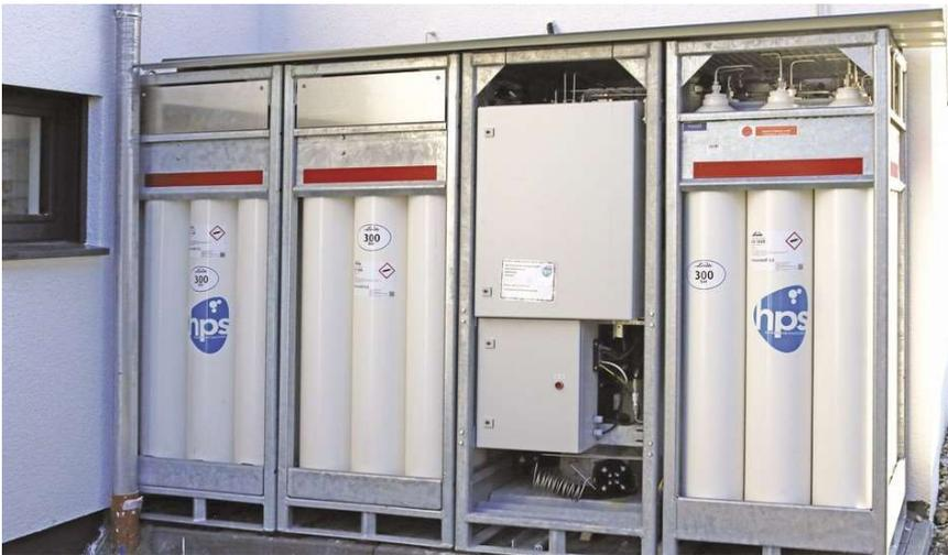
Abbildung 4.2: Wasserstoffspeichereinheit des Picea Speichersystems [11]
