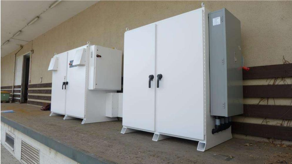
Abbildung 4.3: Proton Onsite C20 PEM Elektrolyseur am Fraunhofer ISE mit einer maximalen Wasserstoffproduktionsrate von 20 Nm<sup>3</sup>/h
