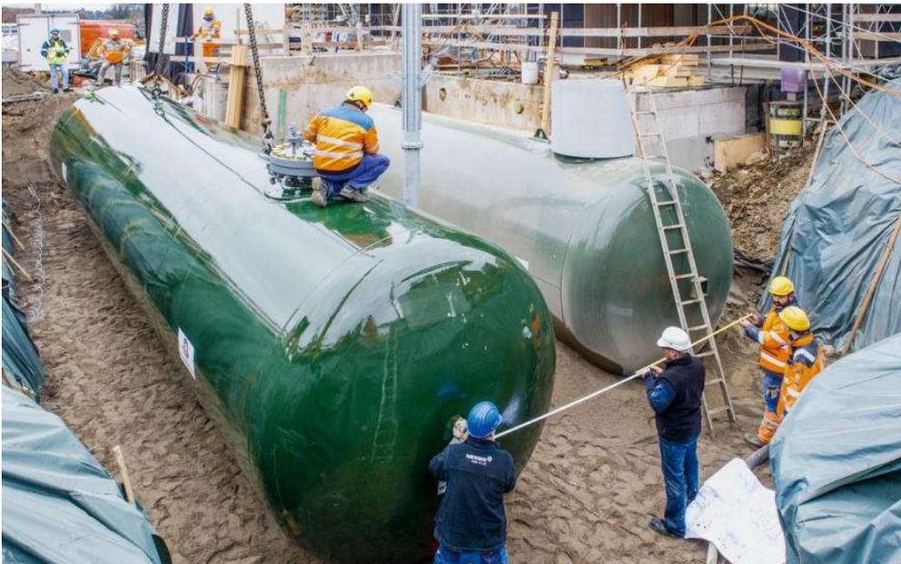
Abbildung 2.3: Einbau der zwei Wasserstoffspeicher mit einem Volumen von jeweils  $100 \text{ m}^3$  [6]
