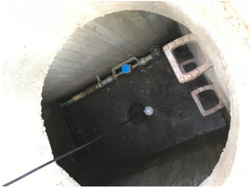
Abbildung 1 Blick in einen Schacht mit Wasserzähler (blaue Abdeckung) der ca. 2 m unter der Erde liegt und durch Absteigen über die Metalltritte rechts, abgelesen wird (Quelle: E-MAKS).
