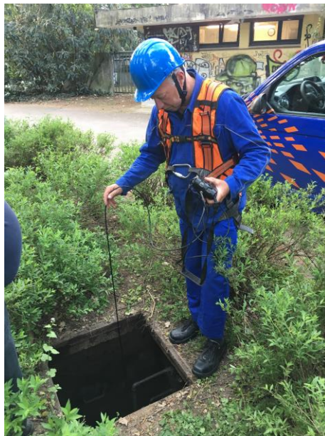
Abbildung 12 Bevor herabgestiegen werden kann, gilt es, für die eigene Sicherheit, eine Messung des Sauerstoffgehalts im Schacht durchzuführen (Quelle: E-MAKS).
