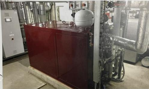
Einbau des innovativen Blockheizkraftwerkes in der Stadthalle in Kehl.
