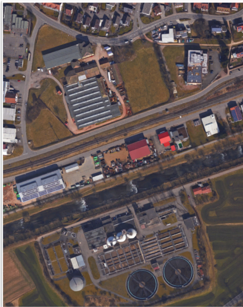
Abbildung 1: Übersicht Kläranlage (unten) und NBG „Alte Weberei“ (oben)
