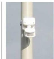
Über den Bewegungsmelder IRS 120 wird die Leuchtdauer minimiert. Das spart vor allem im Winter Batteriekapazität.
