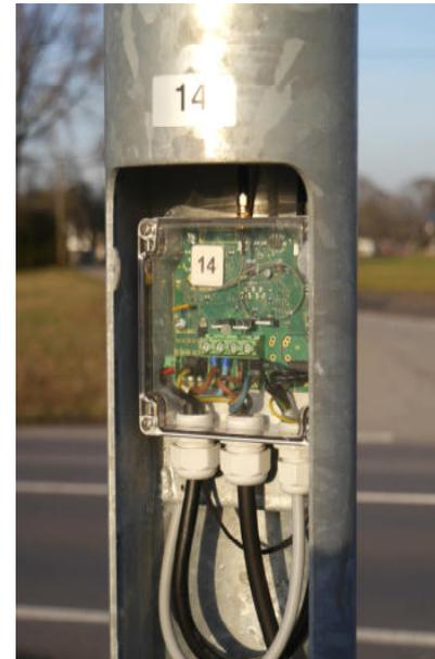
Der interne Datenlogger speichert alle Batteriewerte und Lampenfunktionen der letzten 265 Tage. Über die TeleLED Steuereinheit können, via Laptop und Funkverbindung, verschiedene Betriebsparameter eingestellt werden.
