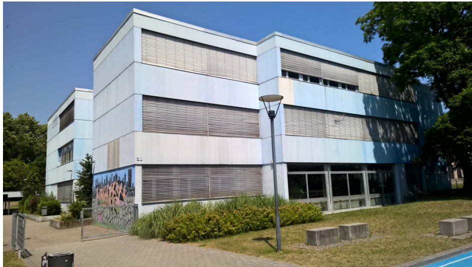
Abbildung 1: Fotografie der Waldbachschule vor der Sanierung
