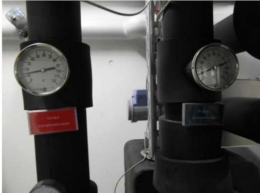
Abbildung 12 VL Entnahmebrunnen RL Schluckbrunnen
