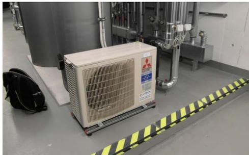
Abbildung 67 Einbausituation Außeneinheit Klimasplitgerät Server UG
