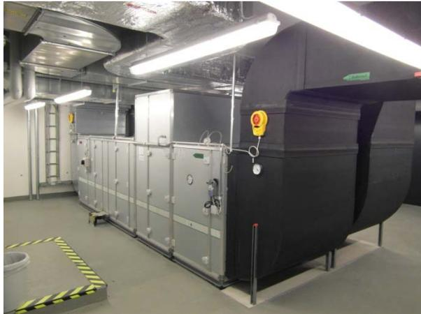
Abbildung 57 Lüftungsanlage 1 Klassenräume Nord
