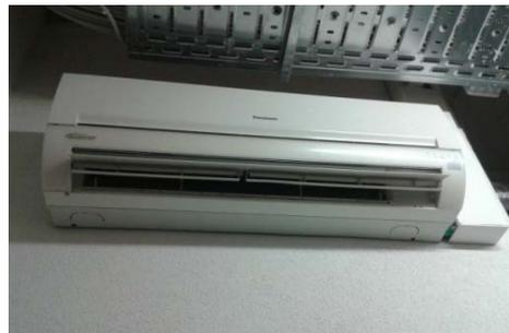
Abbildung 68 Einbausituation Klimasplitgerät Technikraum
