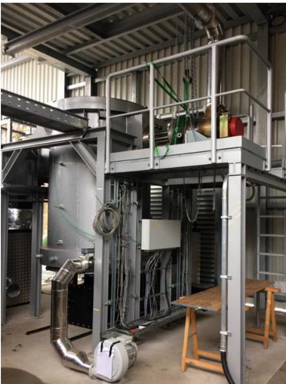
Abbildung 3: Sekundärfeuerungsanlage mit Heißluftturbine
