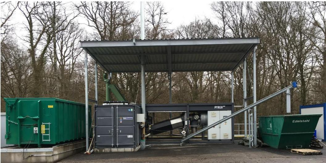
**Foto 6:** Pflanzenkohleanlage Deponie Eichelbuck (links Schubbodencontainer, rechts Kohleaustrag)
