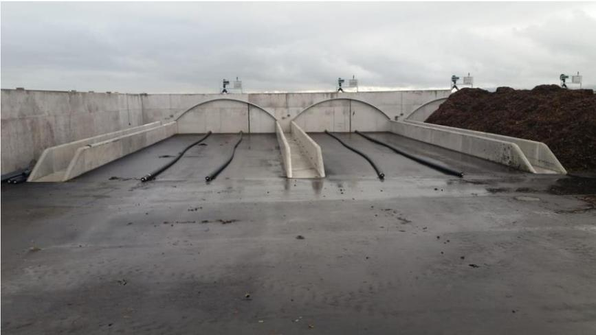
**Foto 3:** Mieten mit Belüftungsrohren
