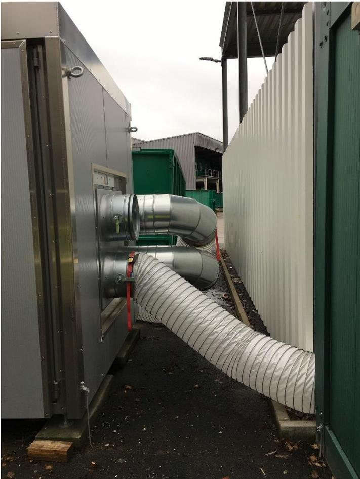
**Foto 5:** Heizzentrale mit Heißluftanschlüssen zum Trocknungscontainer
