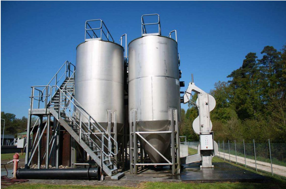
Feinfilteranlage nach dem Einbau der Wasserkraftmaschine im Ablauf
