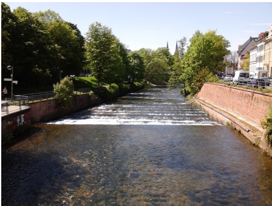
Abbildung 1-1: Blick von der Greiffeneggbrücke auf den Standort
