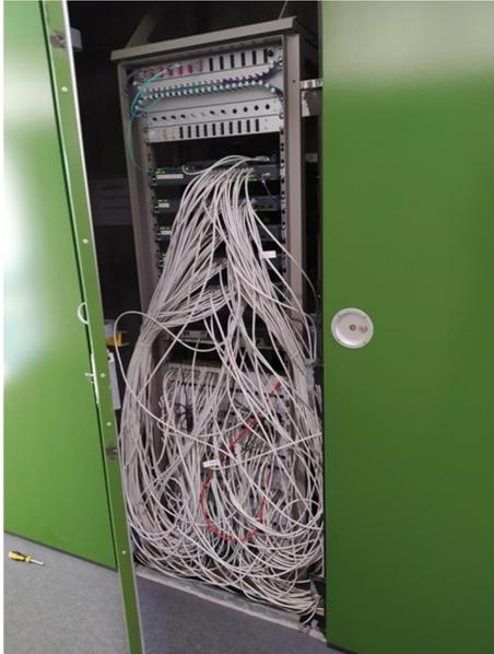
**Abbildung 23: Netzwerkverteiler in der Verkleidung hinter dem Aufzugsschacht**
