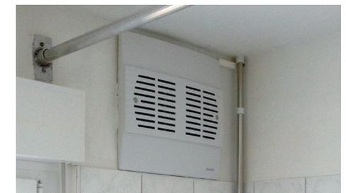
Abb. 3.4: Feuchtegeregelt, fassadenintegriertes Lüftungsgerät mit Wärmerückgewinnung
