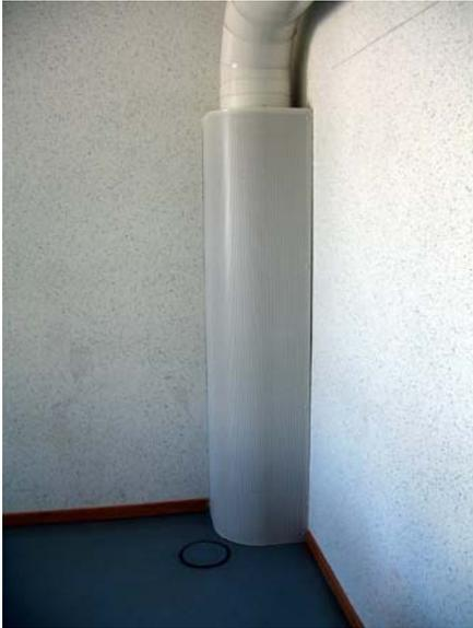
Abb. 3.1: Quellauslass im Computerraum einer untersuchten Schule
