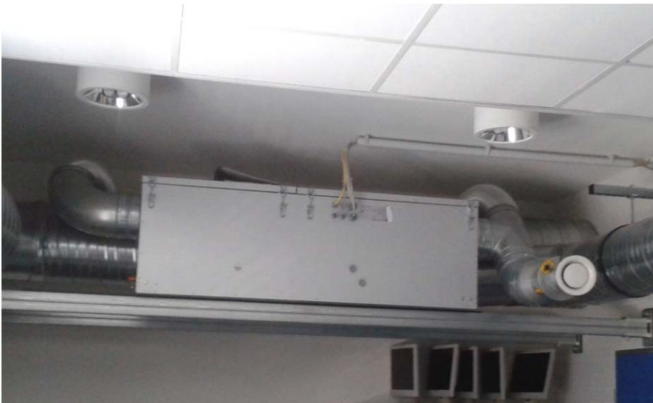
Abb. 2.2: Lüftungsgerät Systemair maxi 1100 EL 400 V
