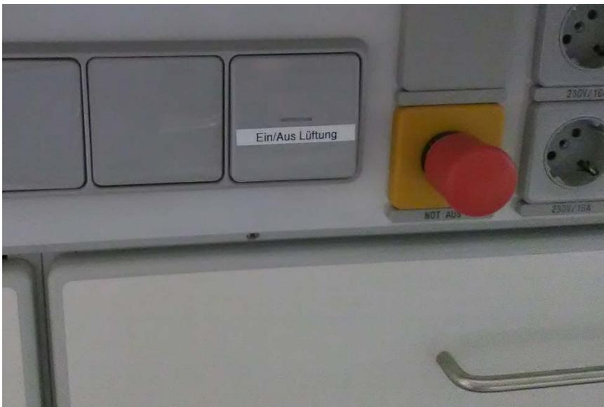
Abb. 2.2: Taster am Lehrerpult zur temporären Deaktivierung des Lüftungsgerätes
