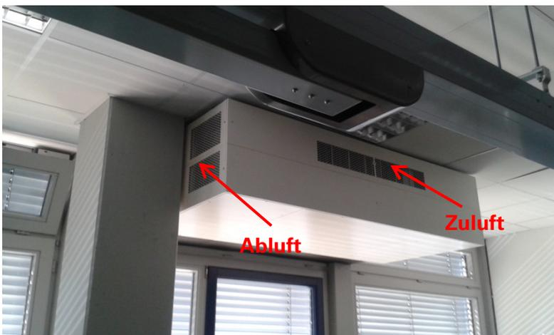
Abb. 3.2: Deckenlüftungsgerät bei dem Zuglufterscheinungen auftreten
