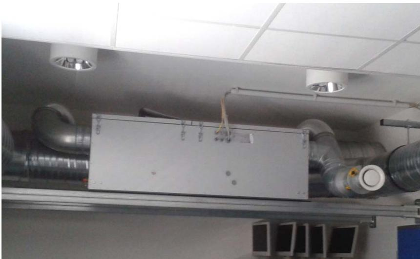
Abb. 3.3: Deckenlüftungsgerät mit zusätzlicher Verrohrung für Zu- und Abluft.
