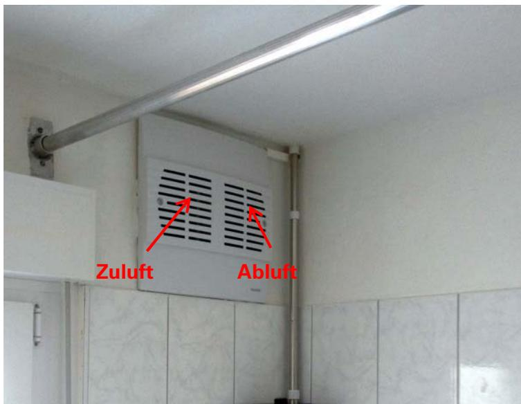
Abb. 3.40: Einbausituation des Lüftungsgerätes des in diesem Kapitel besprochenen Bades im Eichenknick
