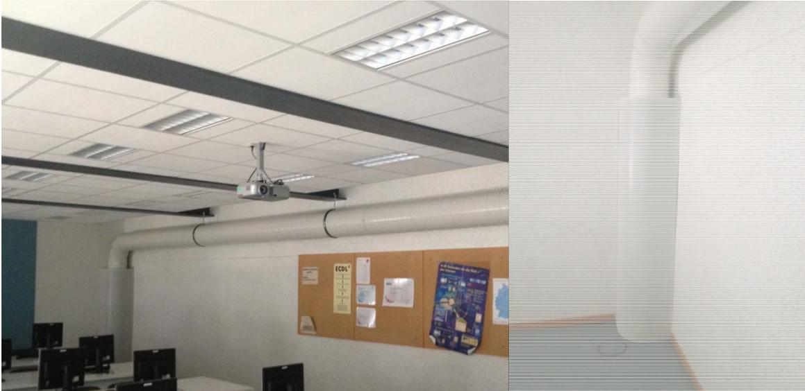
Abb. 2.3: Links: Zuluftanordnung im Computerraum. Rechts: Quellauslass
