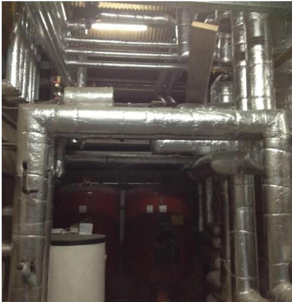
**Abbildung 7 Pufferraum während der Dämmarbeiten**
