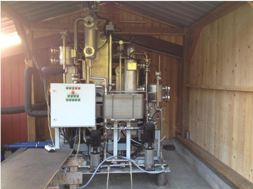
Abbildung 5: Resorptionsanlage während der Montage ohne Dämmung
