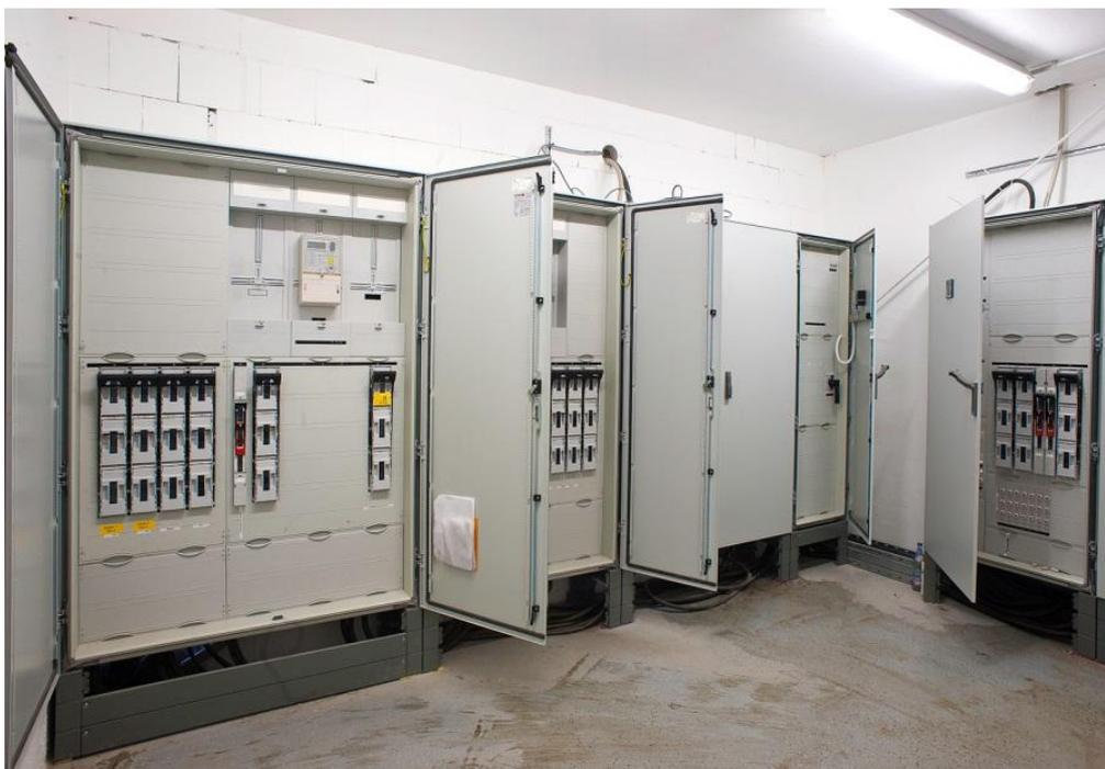
Abbildung 9: Neue Stromverteilung der Energiezentrale des gesamten Hofes
