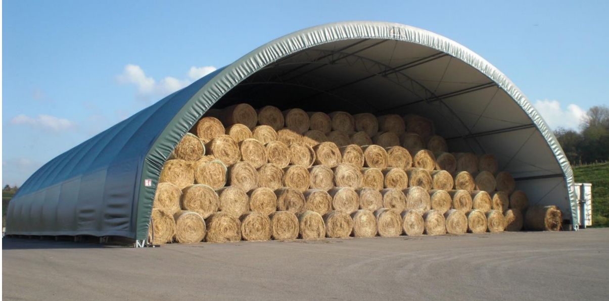
Abbildung 6: Bogenhalle des ZAK zur Lagerung der THG-Rundballen bis zum Beginn der Heizperiode
