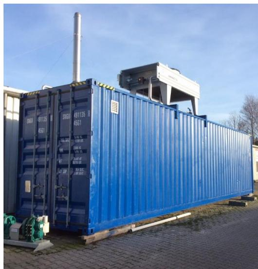
Abb. 27: Container fertiggestellt mit Tischkühler
