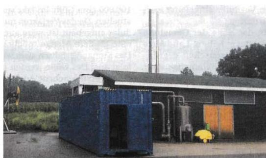
**Die Pilotanlage zur Entstickung ist in einem 40-Fuß-Container untergebracht und steht an einer Anlage im Emsland.**
