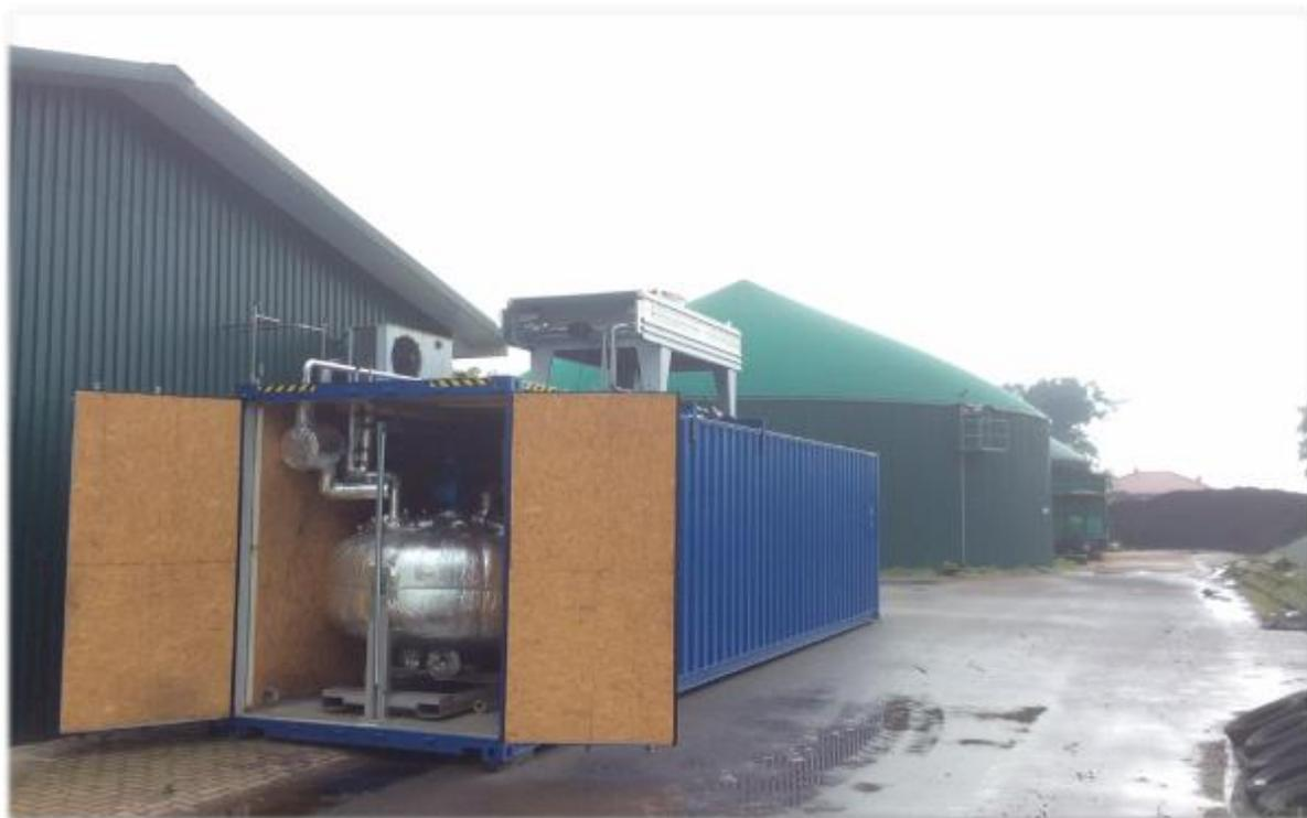
Abb. 29: Entstickungs-Container mit Blick auf Druckbehälter. (links: Maschinenhaus mit BHKWs, Hintergrund: Gärbehälter, Nachgärbehälter, Mais-Silo)
