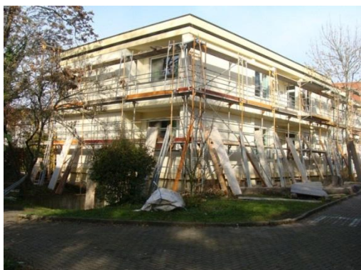
Gerüst für Sanierung am Hort und Verwaltungsgebäude
