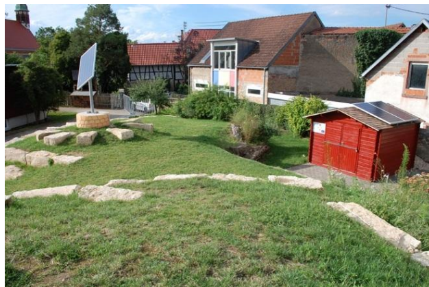
Photovoltaik: links Tracker, rechts Inselsystem
