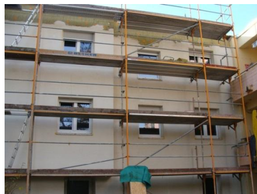
Vollwärmeschutz und neue Fenster Wohngruppen
