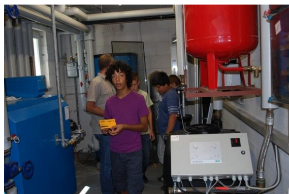
Begehung der Heizungsanlagen
