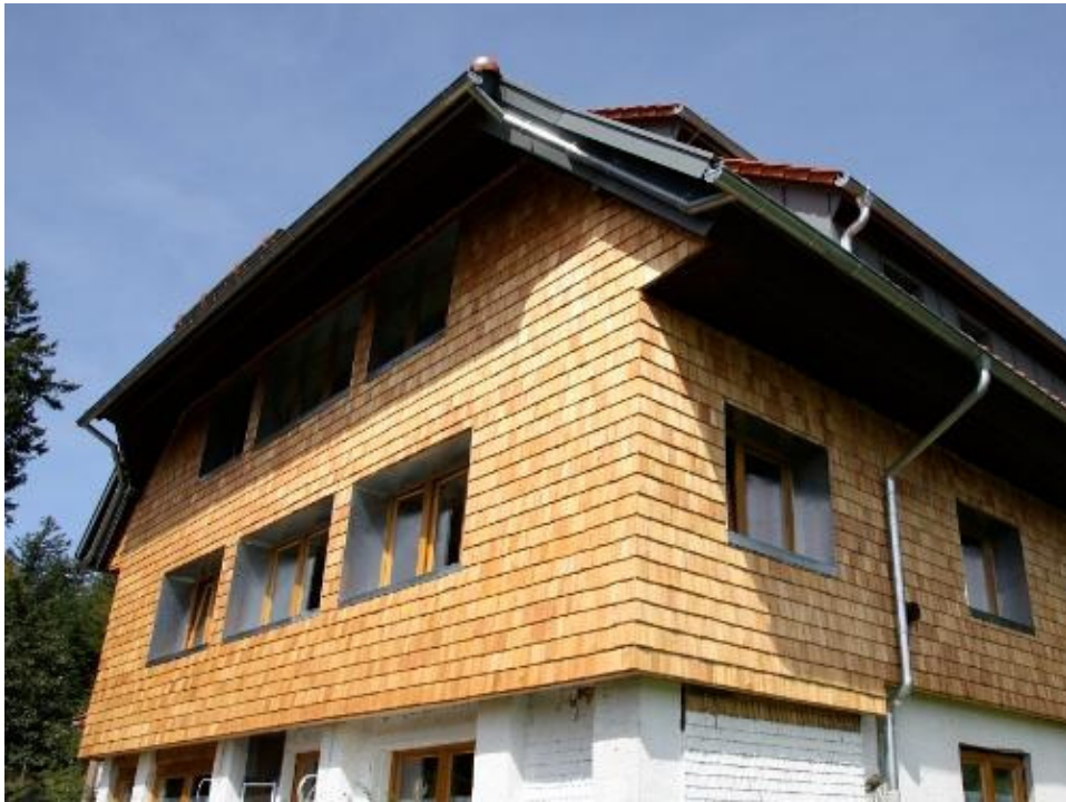
Das Landheim mit neuer Fassade nach der ersten Sanierungsphase
