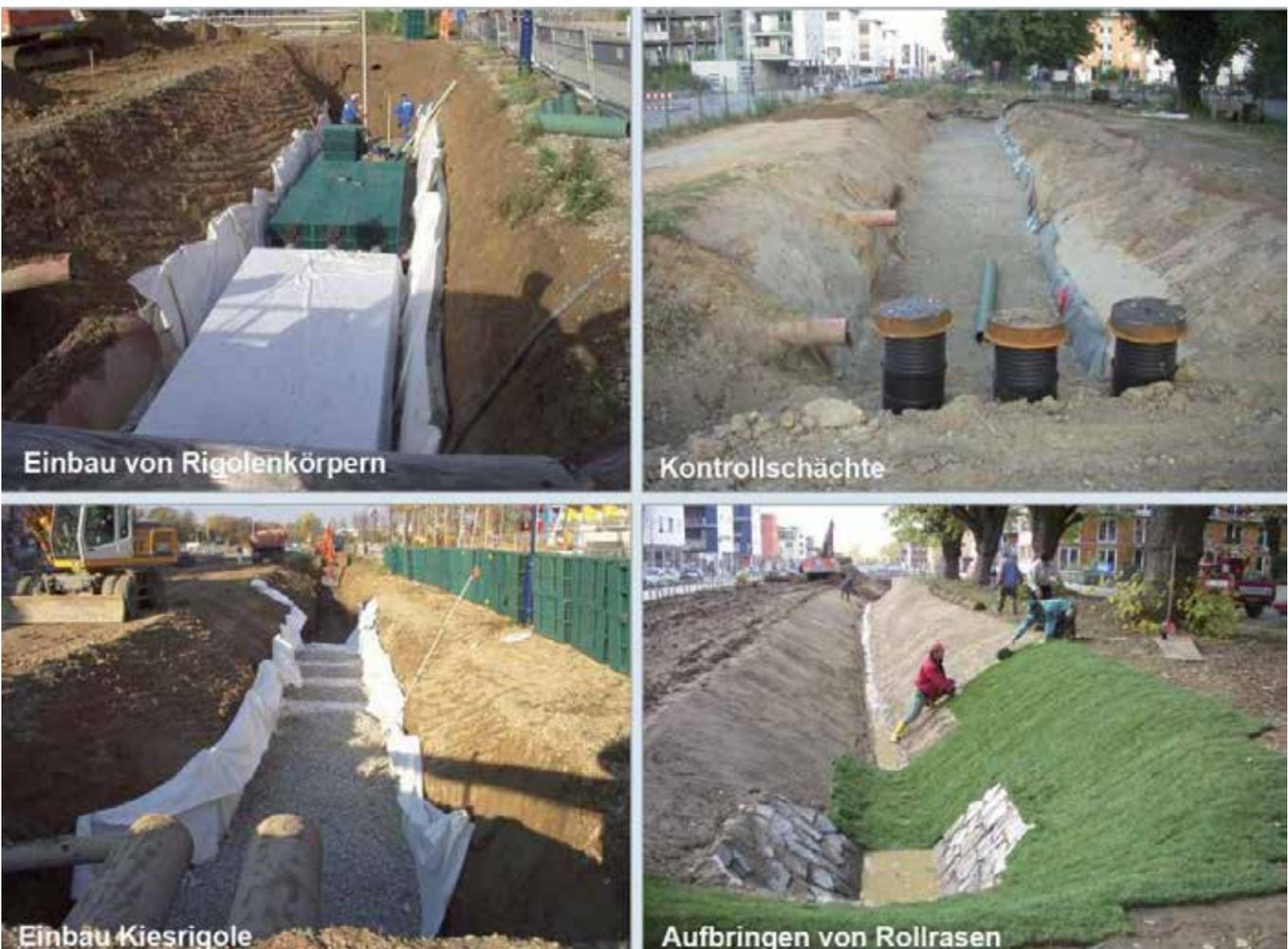
Abb. 18 Bauliche Ausführung der Mulden-Rigolen (Fotos: E. Henkel).
