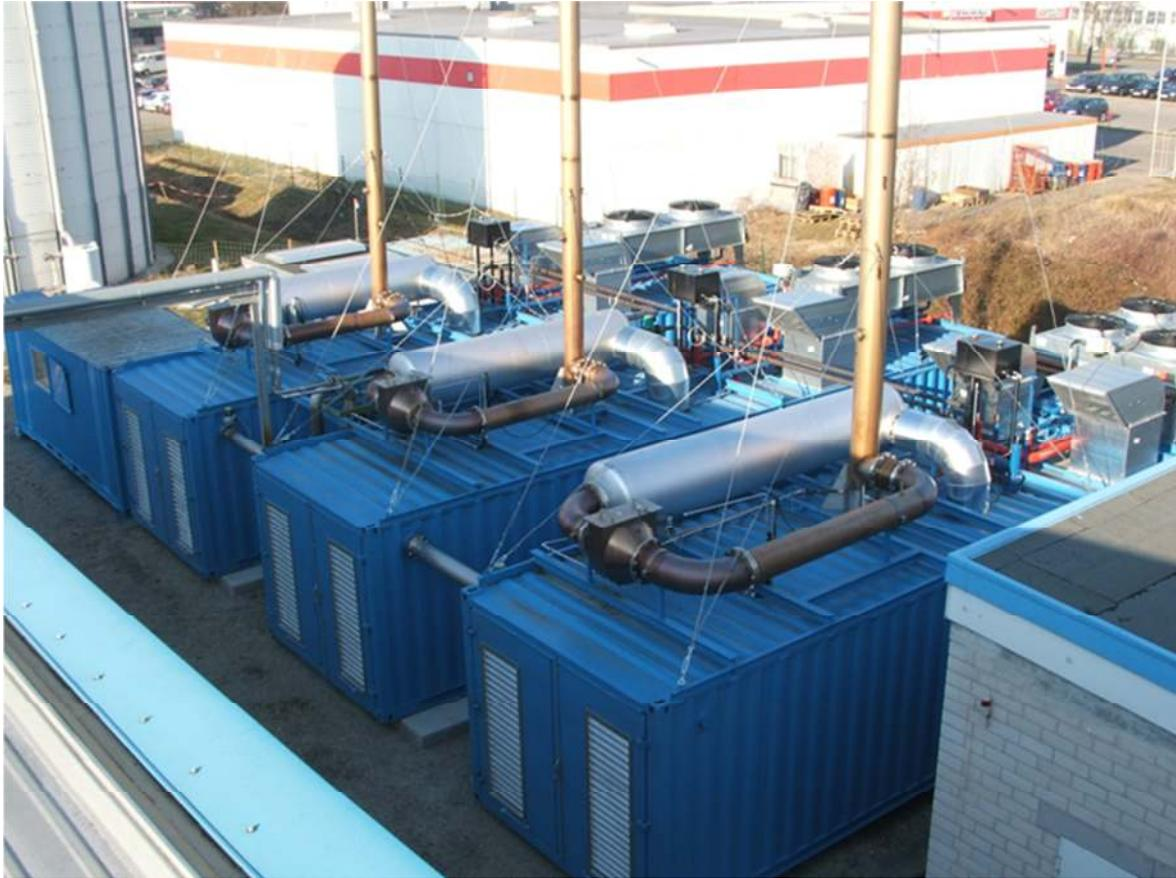
Abbildung 25: Betriebseigene BHKW Biogasanlage
