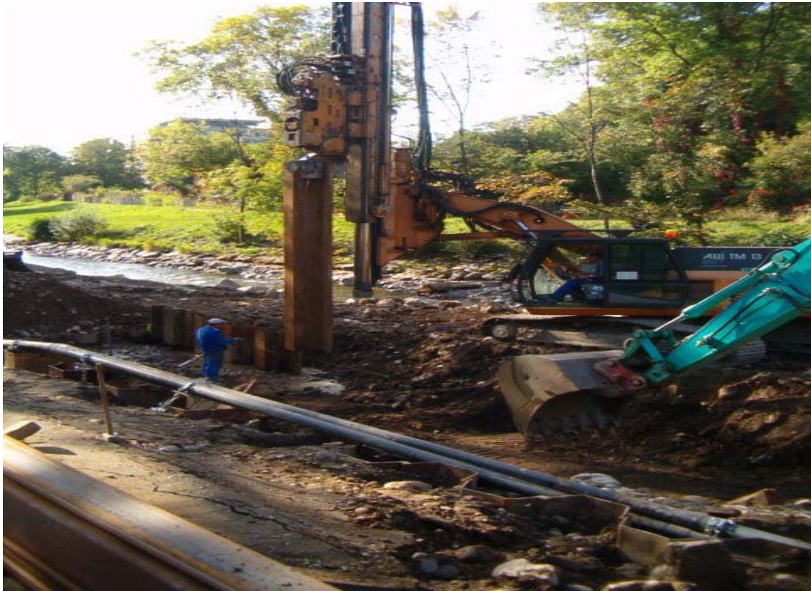
Einbringen der Spunddielen für Spundkasten
