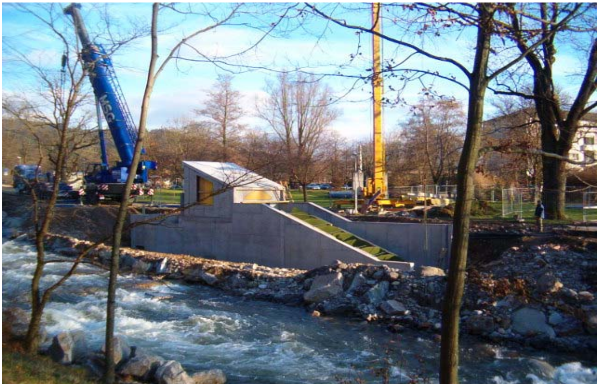
Eingebauter Schneckenkörper und Wasserhaltung
