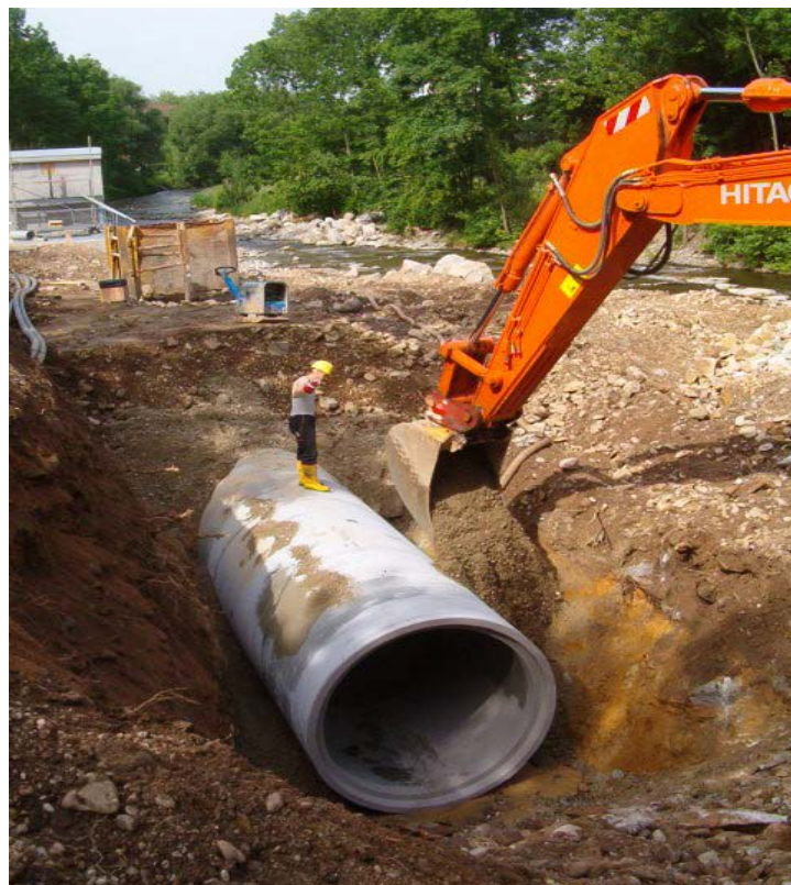
Einbringen des Zulaufrohres zur WKS
