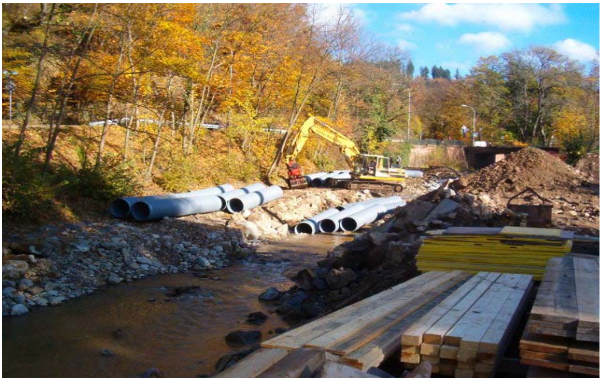
Rohre für Wasserhaltung der Fischtreppebaustelle
