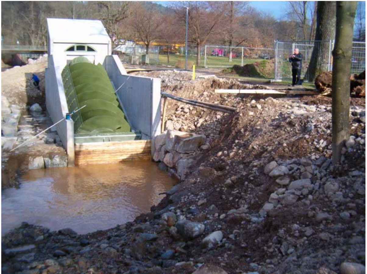
Direkter Blick auf die eingesetzte Schnecke
