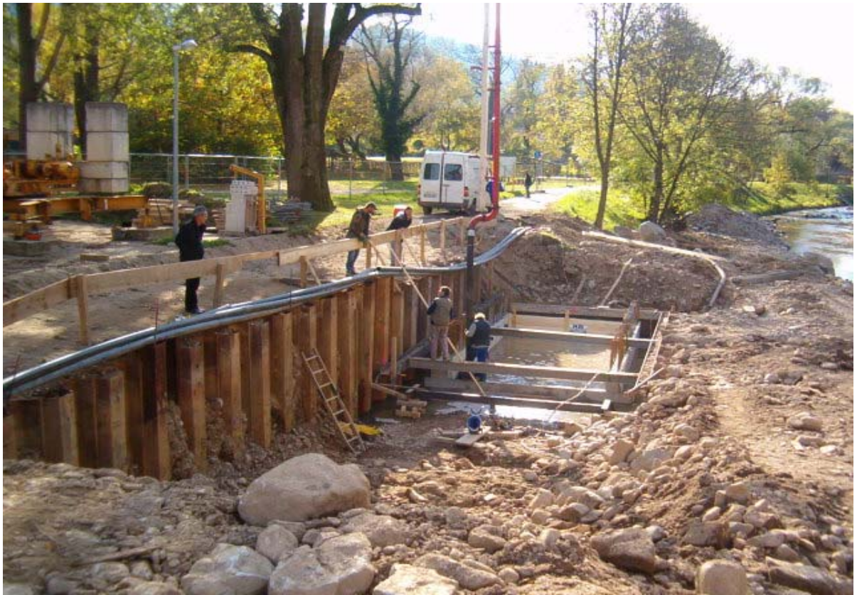
Einbringen des Unterwasserbetons
