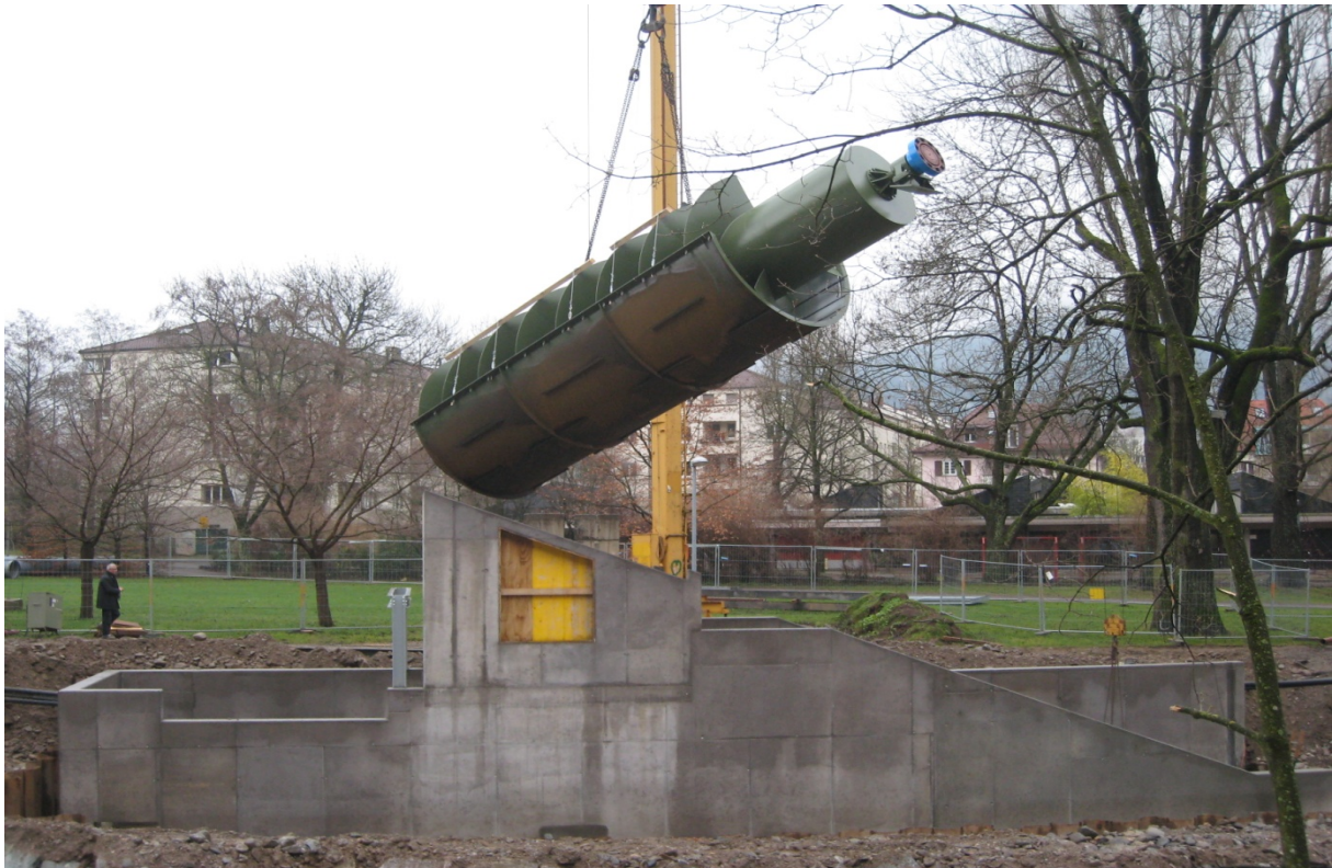
Einsetzen der Schnecke mit Stahltrog
