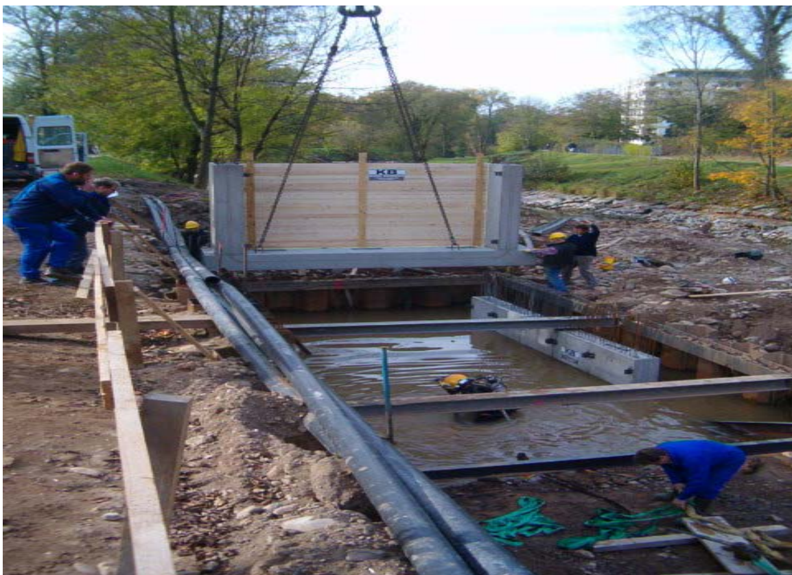
Einbau der Fertigteile unter Wasser für Schneckenkörper
