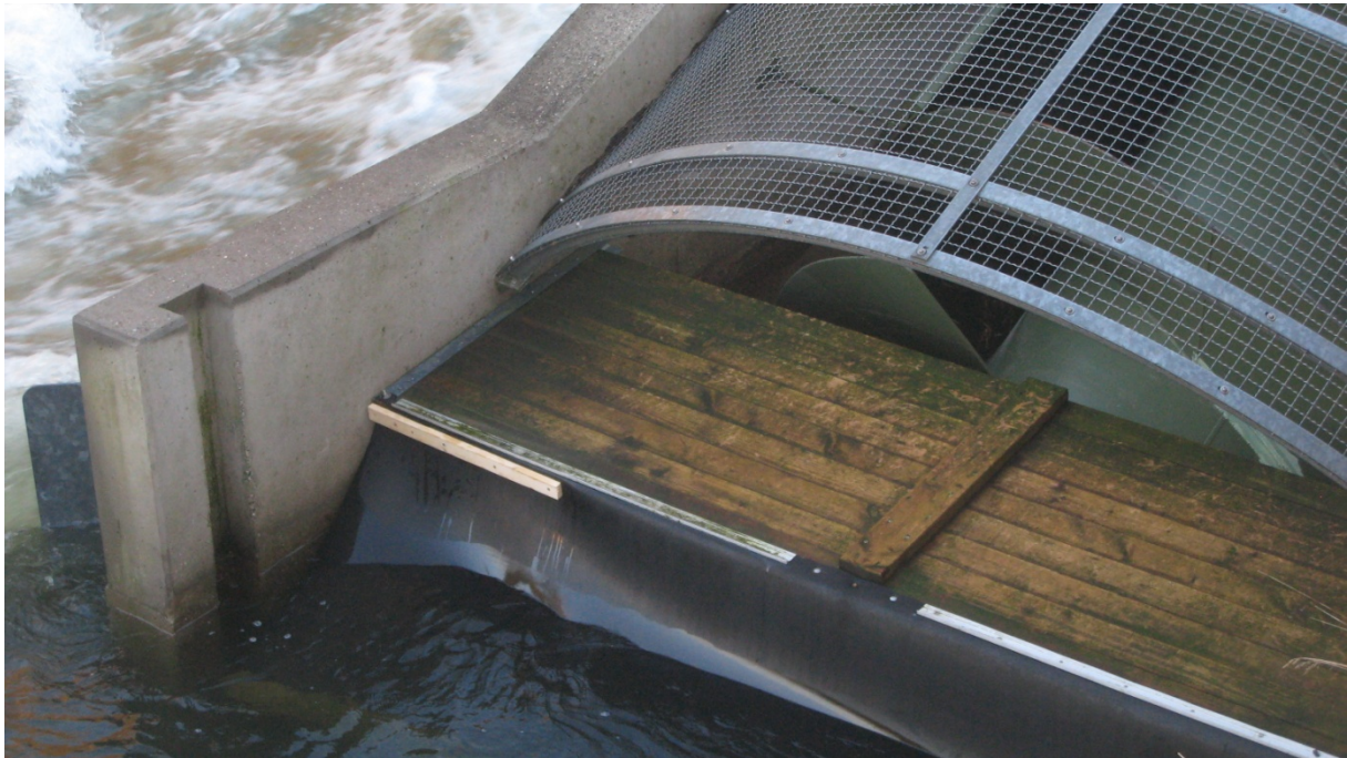
Einhausung zur Verringerung der Ausflußgeräusche
