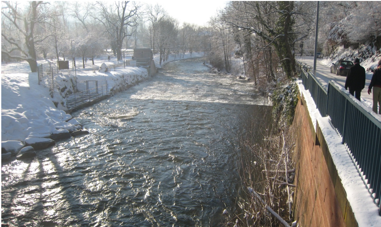
Blick von der Sandfangbrücke auf WKS und Sohlrampe
