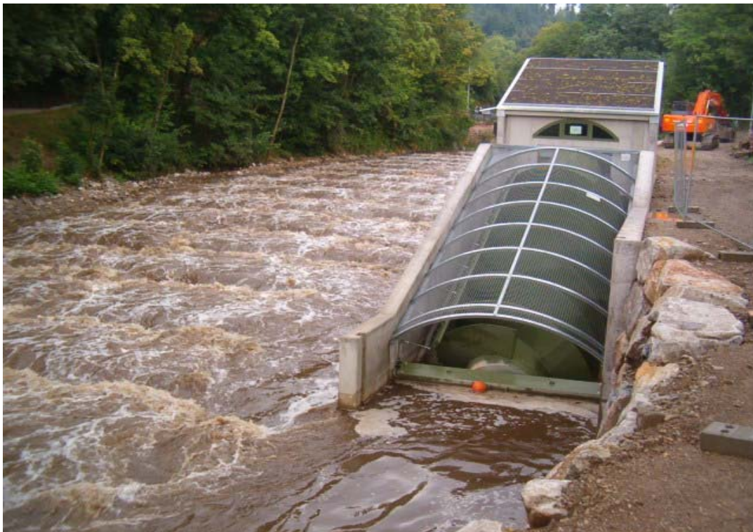
Eine der Hochwassersituationen während der Bauphase
