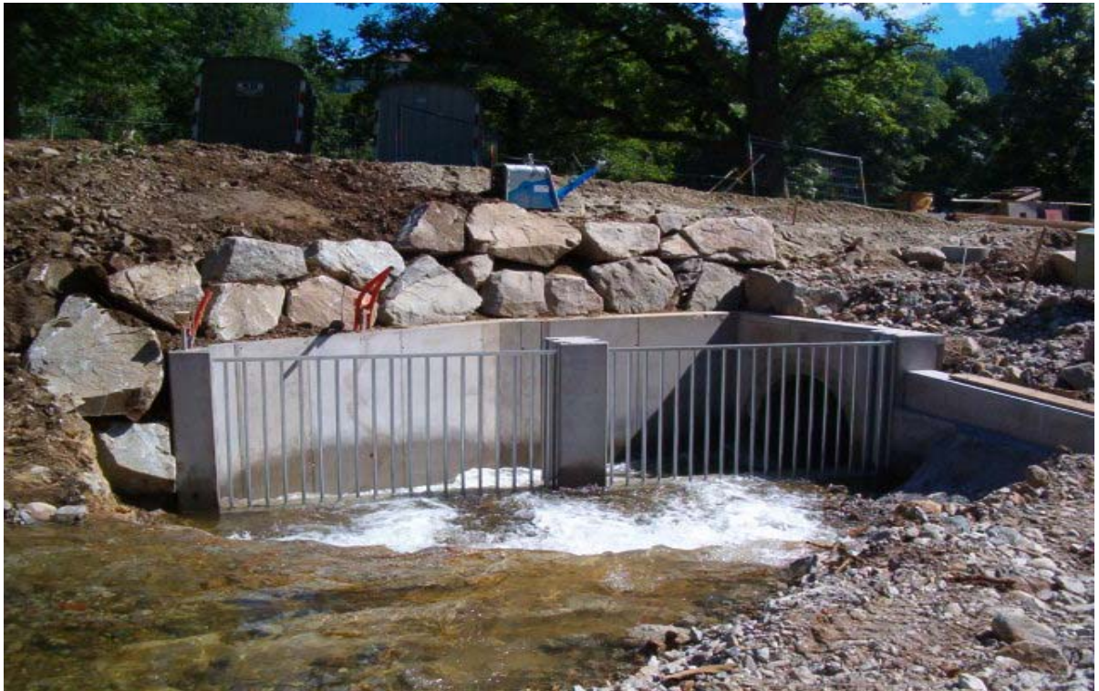
Einlaufbauwerk mit Grobrechen
