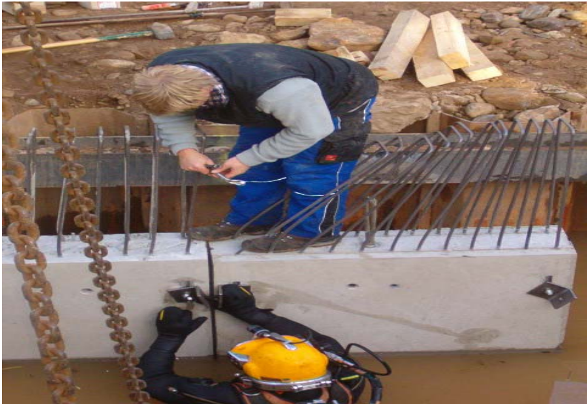
Befestigung der Unterwasserfertigteile mit Taucher
