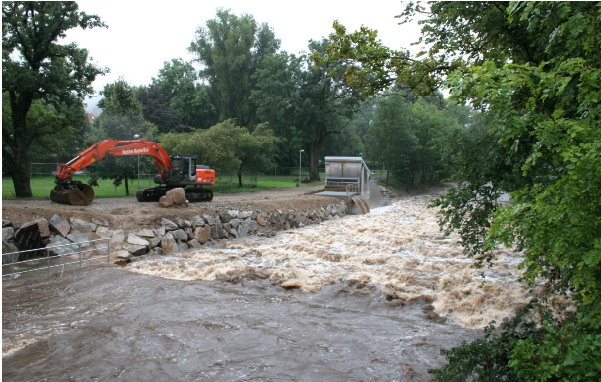
Eine der Hochwassersituationen während der Bauphase
