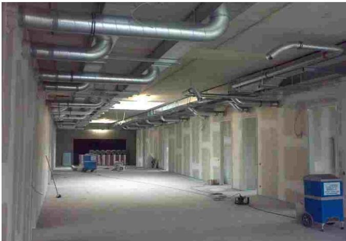
**Abb. 13: Lüftungskanäle im OG - Ausbauphase**
