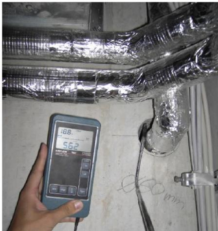
Rohrdurchführung in HT-Lüftung F105 zum Raum F110 (5,62 m/s): Abdichtung fehlt.
