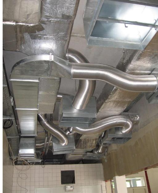
**Abb. 17 u. 18: Lüftungskanäle der Spül- und Regenerierküche (unverkleidet)**
