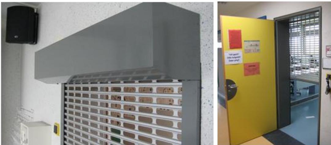
**Abbildung 6: Aufgesetzte Rollläden mit ausgestanzten Metallsegmenten (links: Innenseite des Fachraums mit Rollladenbox, rechts: Klassenzimmertür zum Flur öffnend und Blick in den Fachraum bei teilweise geöffnetem Rollladen)**
