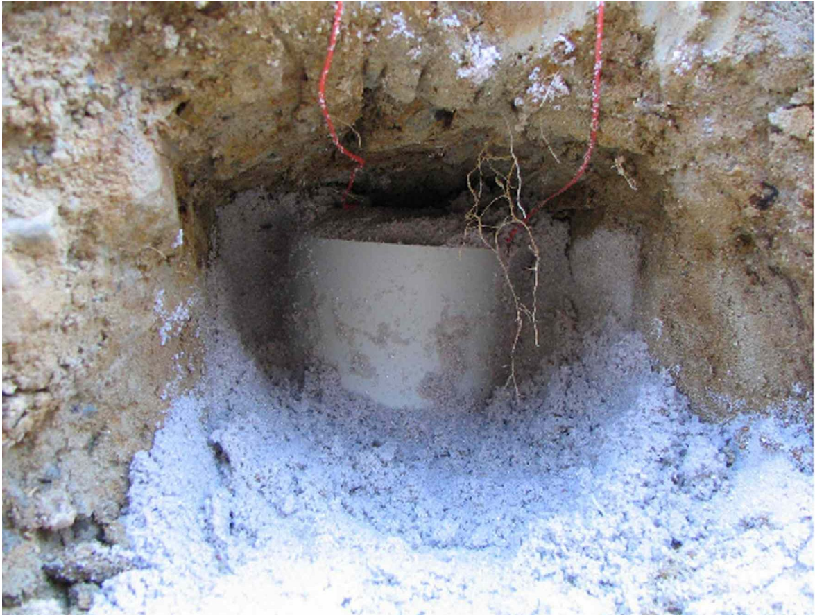
Abbildung 10: Einbau der SIA.
