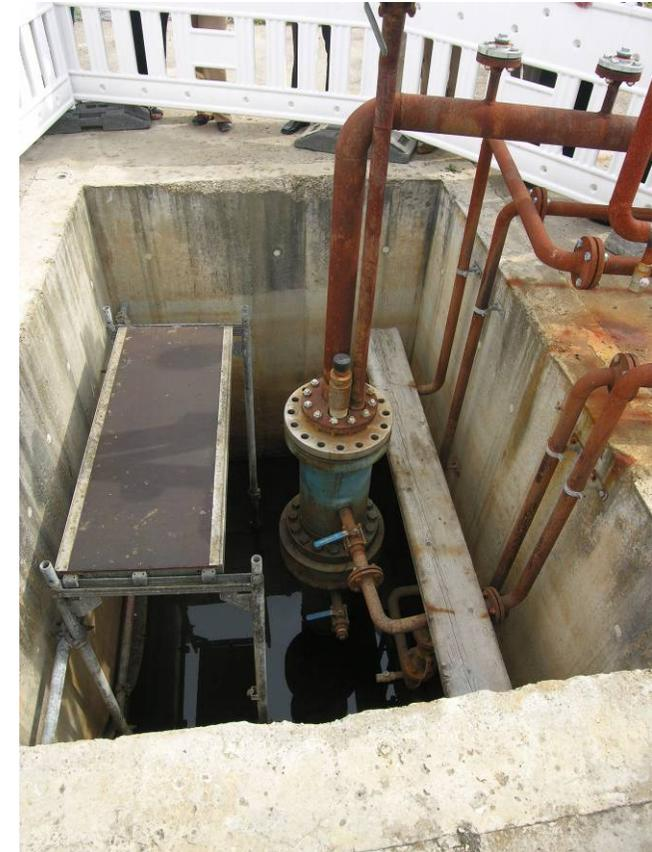
Bohrloch mit Verrohrung
