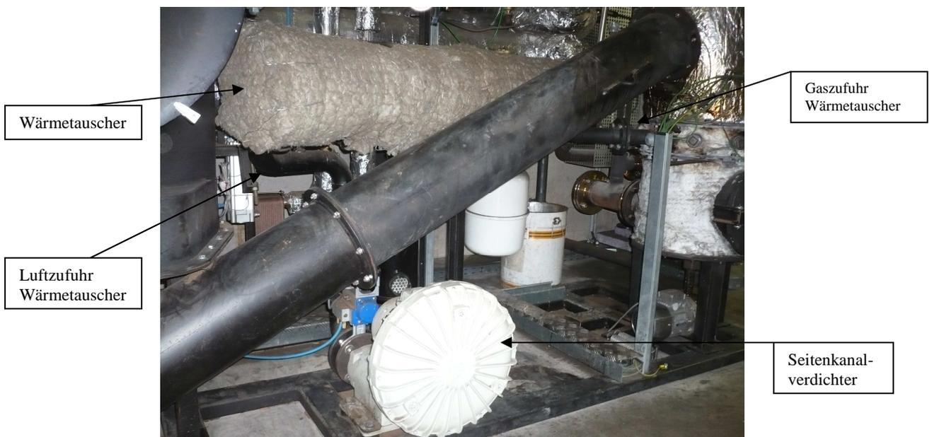
**Abbildung 11: Druckgebläse und Wärmetauscher**
