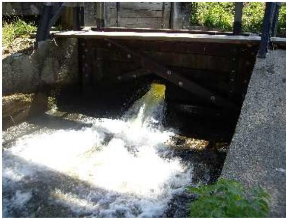
**Abb. 3** Ausleitungswehr Acherner Mühlbach, Schütz mit Dotationsöffnung
