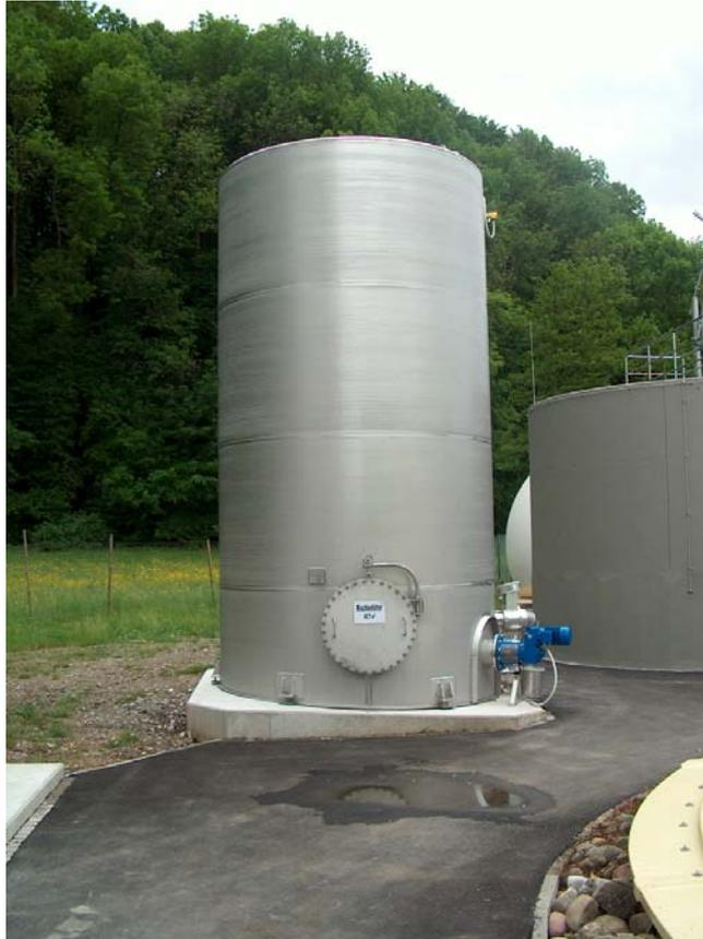
Im Mischbehälter werden Primär- und Sekundärschlamm vermischt und zur Faulung in die Hochlastfermenter gepumpt.
