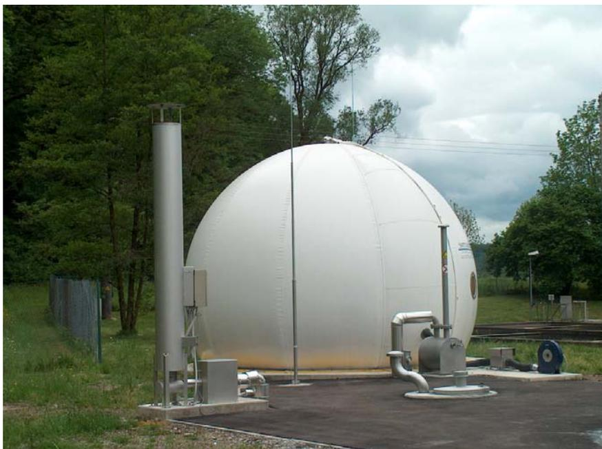
Ein moderner Gewebebehälter dient als Zwischenlager für die Biogase
