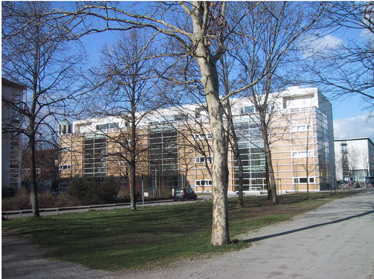
Bild 1.1 IUK Südfassade als Energiefassade EG bis 2.OG.
