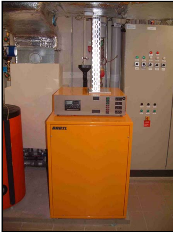
Grundwasserwärmepumpe
