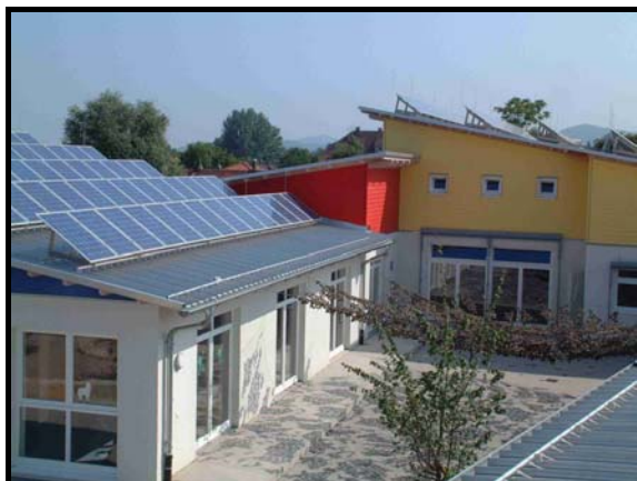
Ansicht in den Hof
