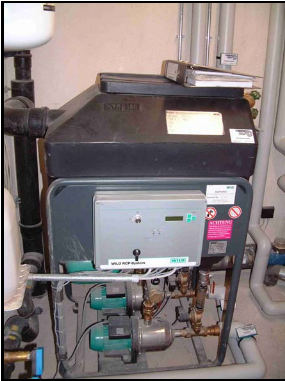
Blick auf die Regenwasserzisterne
