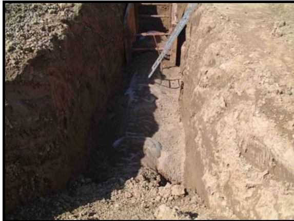
Erdwärmetauscherrohr während der Bauphase
