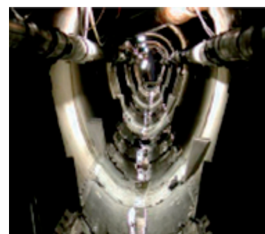
Abb. 27 Beispiel für ungünstige Gestaltung der Anlage aus kanalbetrieblicher Sicht
