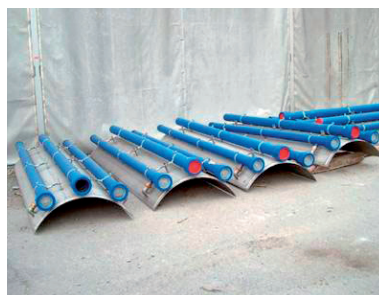
Abb. 16 Unterseite der für die Einlage in die Rohrschalung vorgesehene Wärmetauscherelemente
