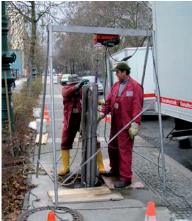
Abb. 18 Einbringung der Wärmetauscher durch einen bestehenden Schacht
