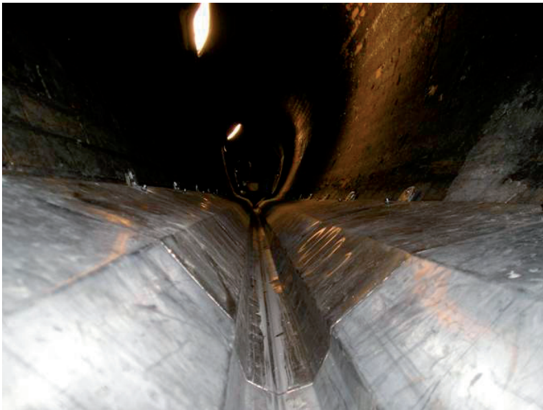
Abb. 28 Beispiel für günstige Integration des Tauschers mit Banketten
