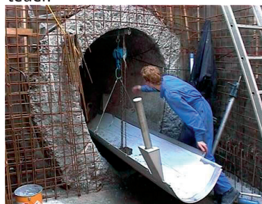
Abb. 14 Nachträgliches Einschleiben Wärmetauscherelemente
