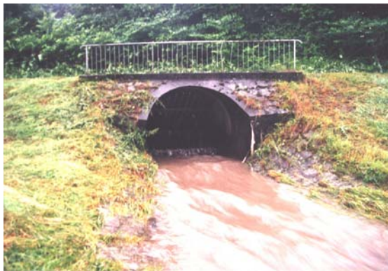
Abb. c1.2: Entlastungsereignis der Mischwasserkanalisation in die Dreisam am 6.6.02 (Rieser, M. 2002)
