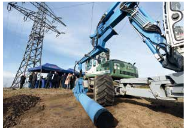
Vernetzte Trinkwasser-Infrastruktur: Von ihrem Wasserwerk in Hausen a. d. Möhlin versorgt badenova nicht nur ganz Freiburg mit hochwertigem Trinkwasser, sondern seit 2020 auch Breisach und einige Nachbarorte. Hier ein Bild vom offiziellen Baubeginn der Leitungsverlegung.
