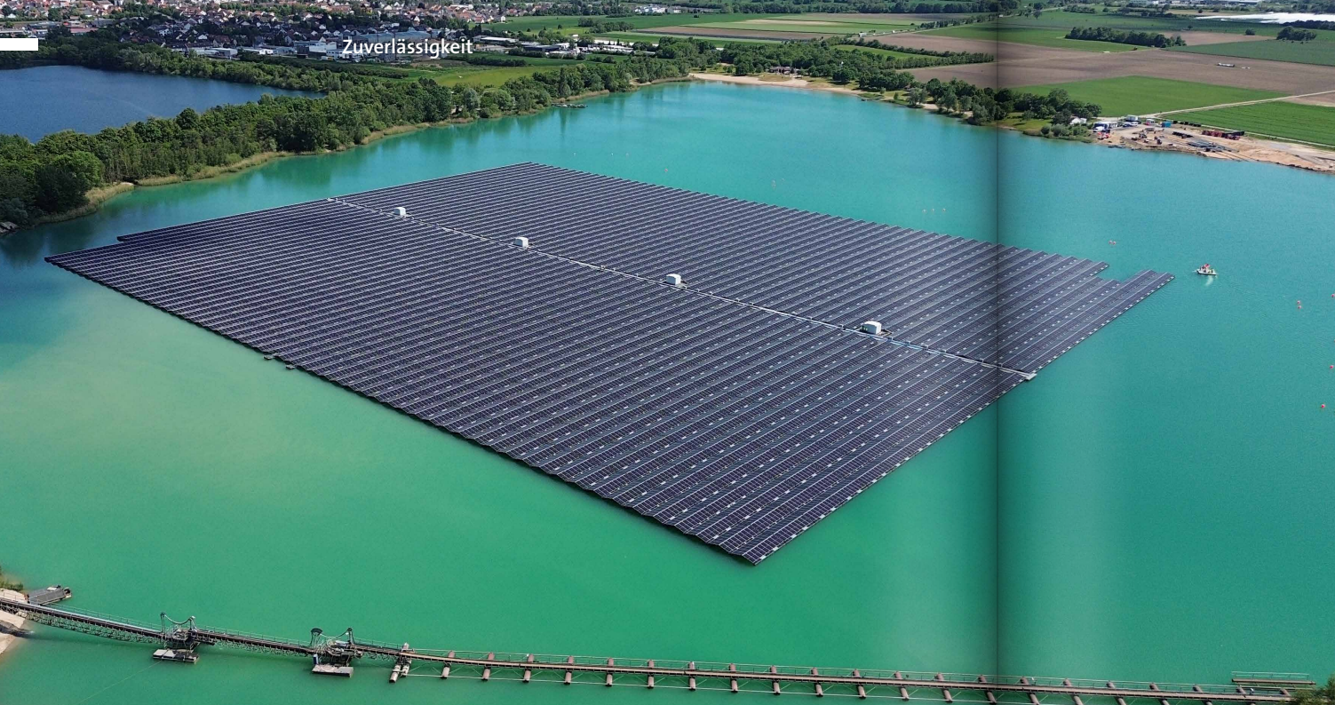
DIE SCHWIMMENDE PV-ANLAGE
